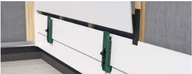
3. Positionner la prochaine lame HardiePlank®
