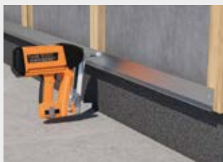
Fixation du profilé de départ et de ventilation
