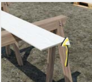
Traitement des chants avec ColourPlus™ avant le montage des lames
