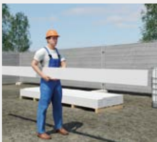
Les lames doivent toujours être manipulées sur les chants afin d'éviter tout risque de déformation.
