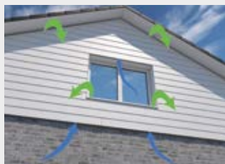
vert : sortie d'air bleu : entrée d'air
