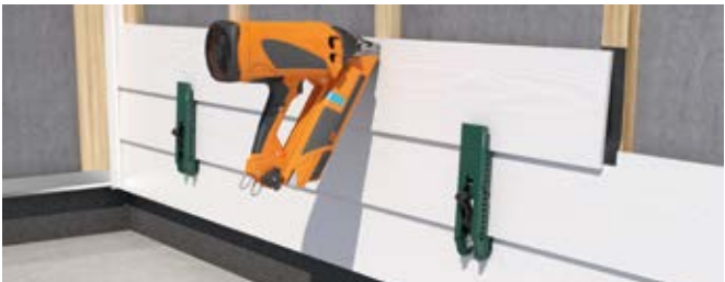
4. Fixer les lames sans les pré-percer avec des clous ou des vis.
