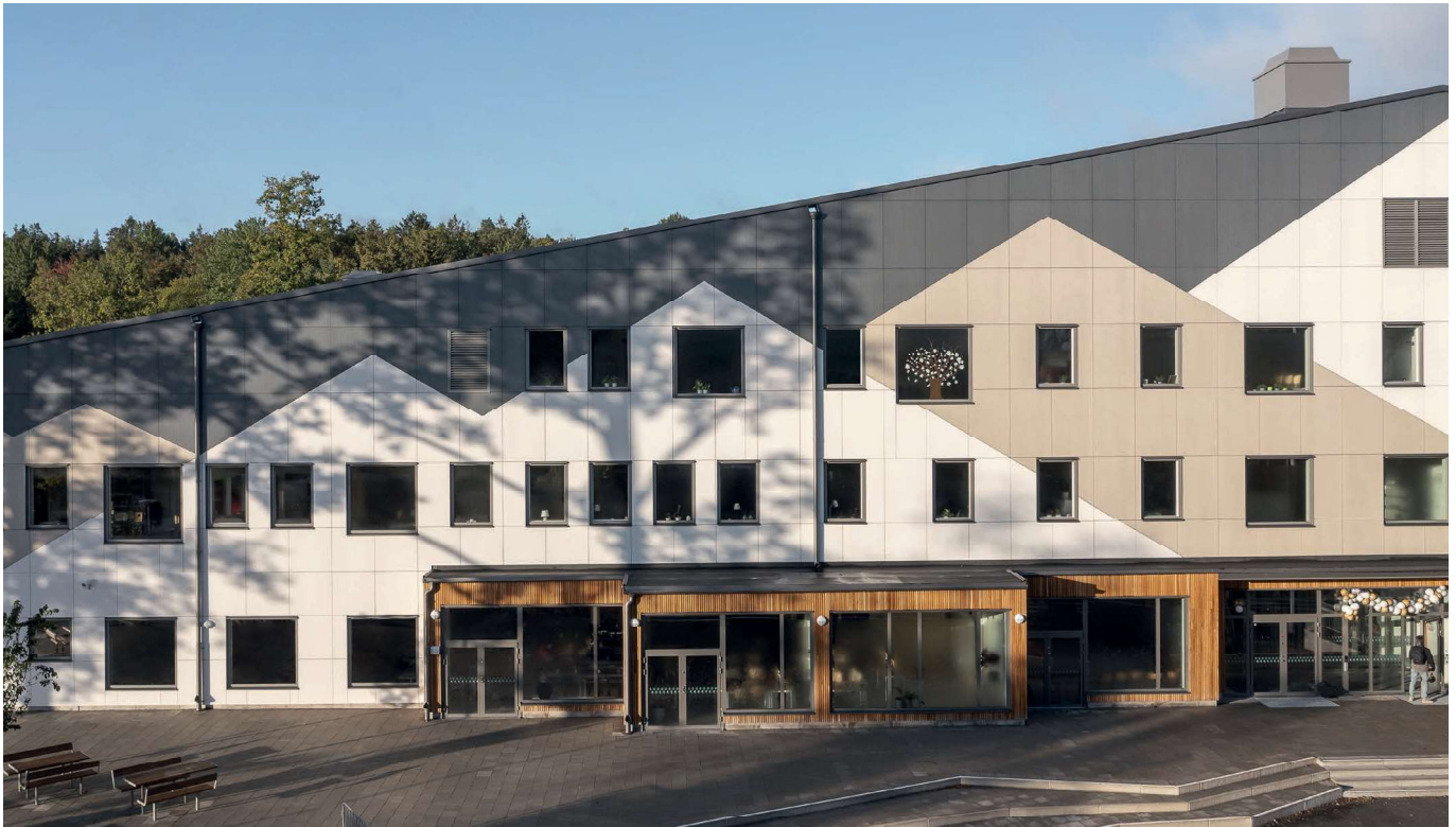
Långsjöskolan Huddinge, Segeltorp, Suède. Architecte: Tyréns, Suède et Arkitema Architects, Danemark. Photographe : BaraBild Sverige AB, Stockholm, Suède.
